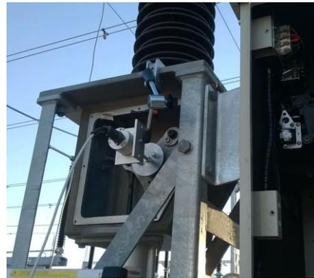
*Transductor giratorio digital montado en el interruptor ABB LTB 245 kV SF6*
